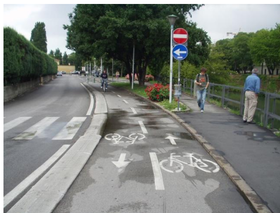
Padova (separazione con sopraelevazione del piano della ciclabile e cordolo da 50 cm.)
