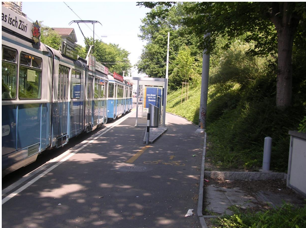
Aggiramento delle fermata del tram dotata di pensilina - Zurigo
