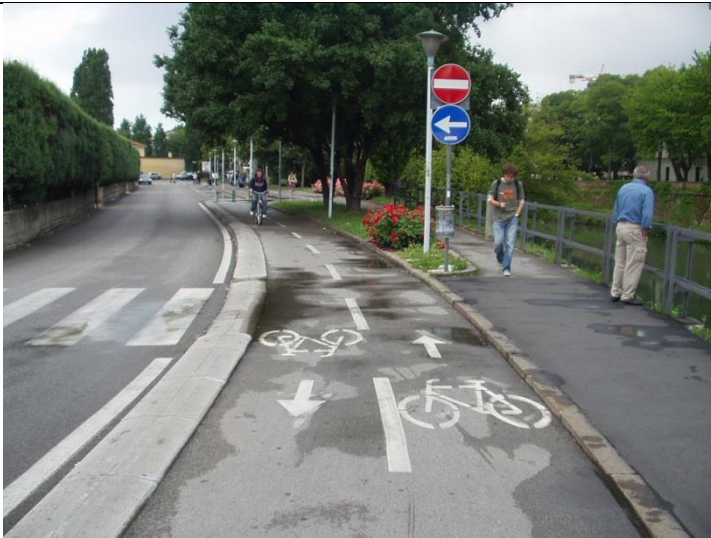
Elemento separatore realizzato con doppio cordolo coricato
