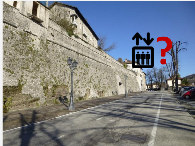
Scarsa visibilità dell'accesso all'ascensore del Municipio in via Campo Mosto
