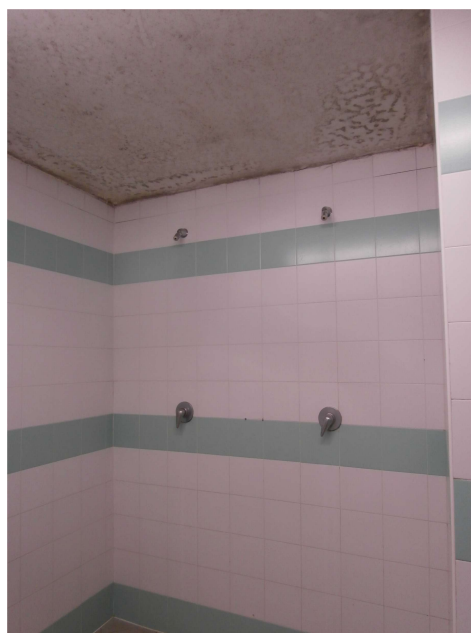
Docce spogliatoio 1 locali
