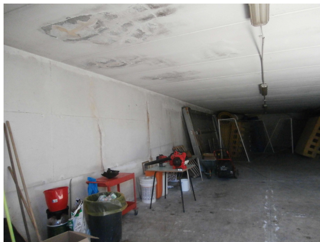
Deposito tribuna ovest Campo calcio e pista di atletica
