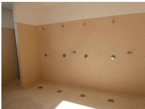
Area docce spogliatoio locali
