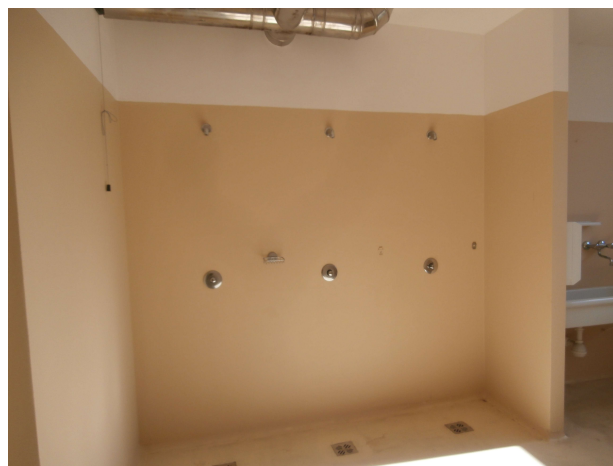
Area docce spogliatoio locali
