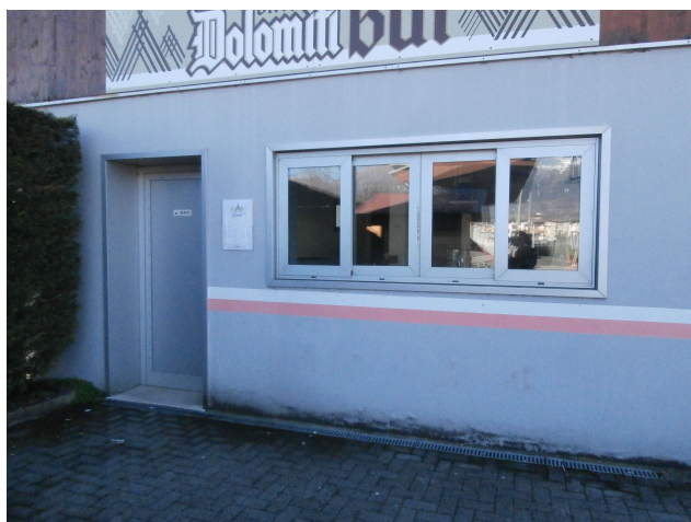
Ingresso area bar
