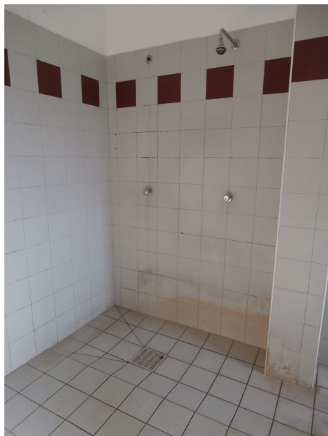
Area docce spogliatoio locali
