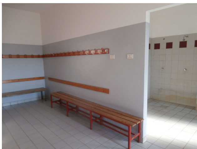
Spogliatoio locali e ingresso area docce
