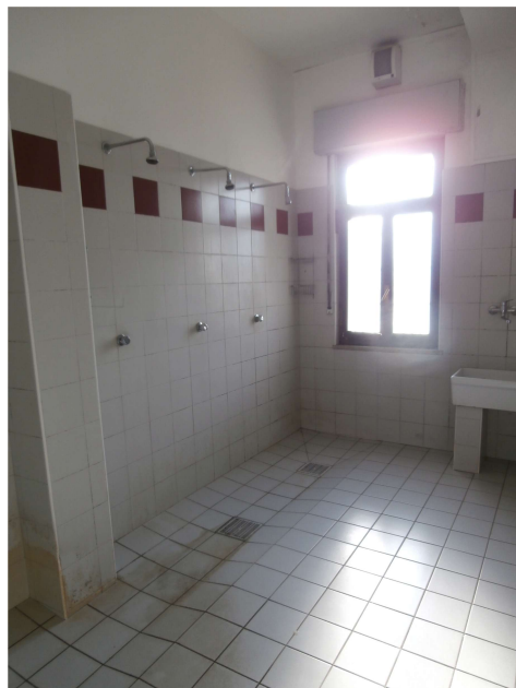
Area docce spogliatoio locali
